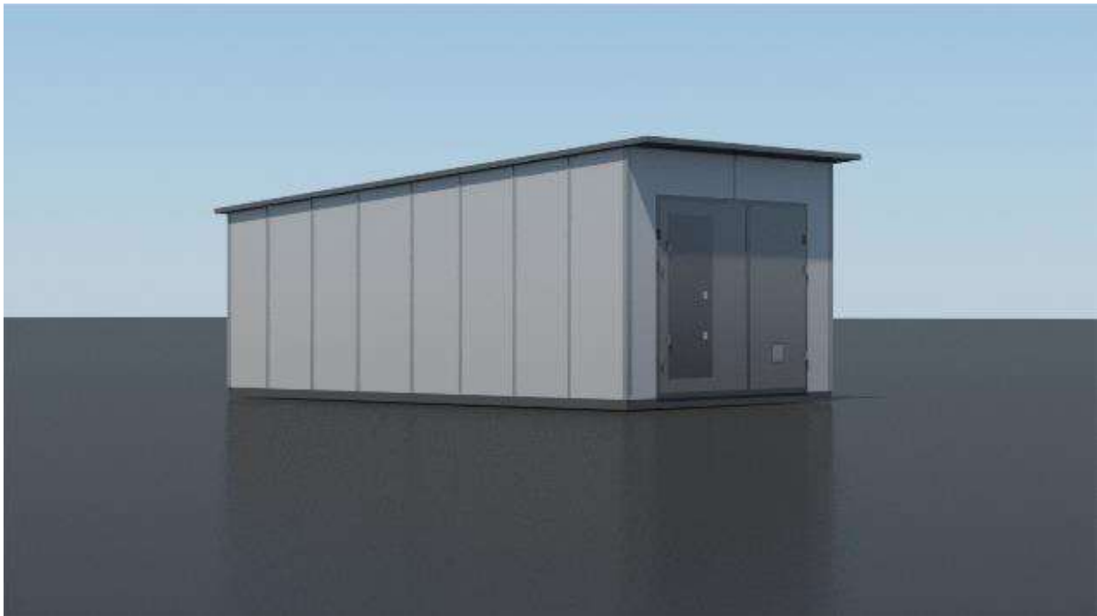
Вариант N 5 Материал стен: профилированный лист (для гаражей, расположенных на промышленных территориях)
